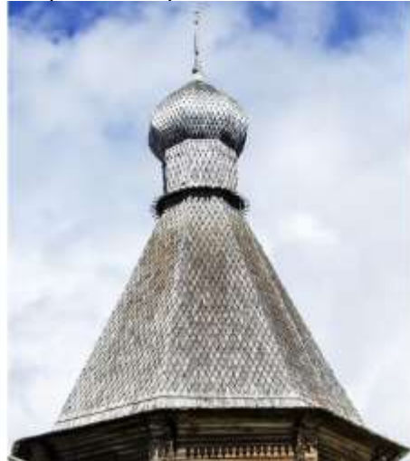
Покрытие шатра лемехом
