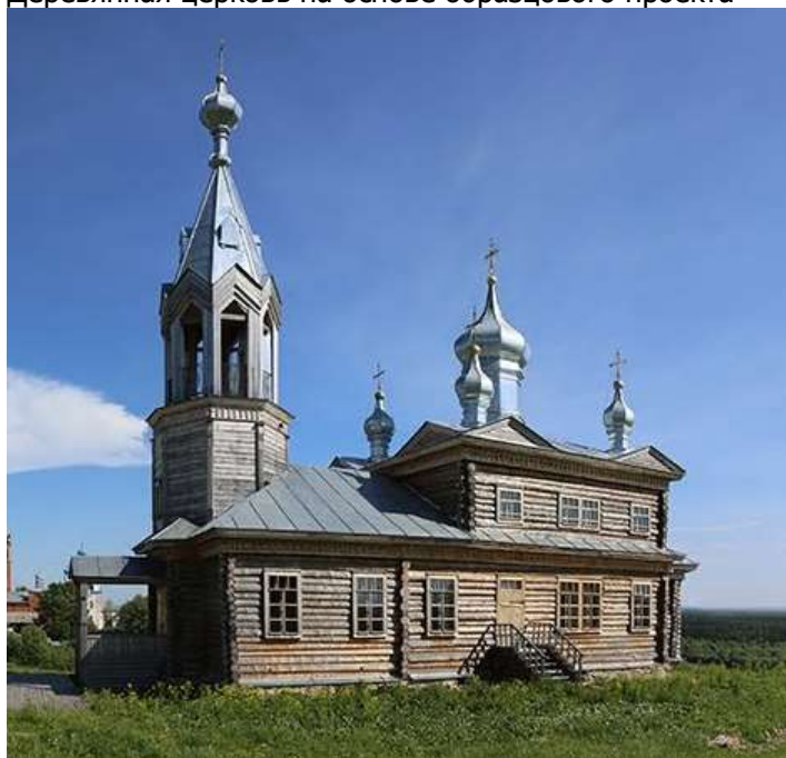
Деревянная церковь на основе образцового проекта
