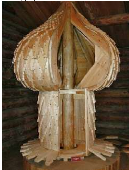
Конструкция главки
