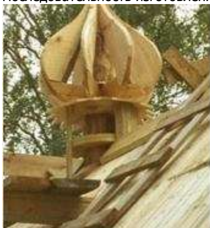
Последовательность изготовления главки
