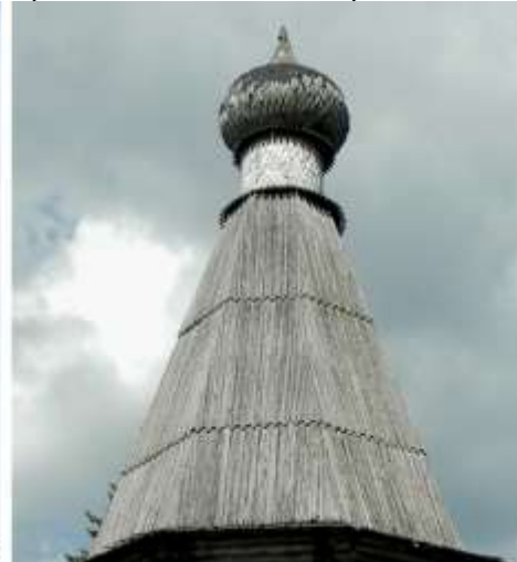
Три "юбки" тесового покрытия
